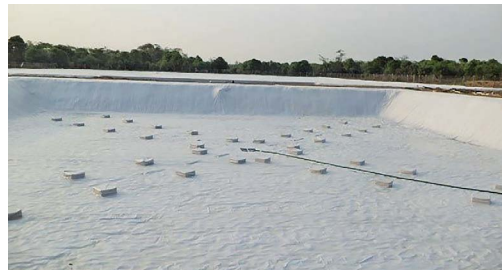
Figura 3. Área de captación de agua de lluvia (arriba) y Olla de almacenamiento recubierta con geomembrana (abajo).
