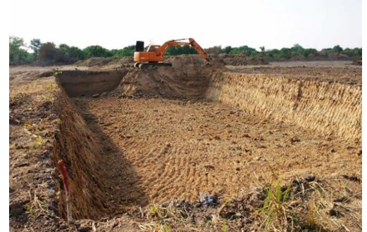
Figura 2. Cuenca de captación de agua de lluvia (arriba) y Excavación para el almacenamiento del agua de lluvia (abajo).
