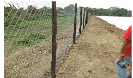
Figura 4. Válvula de paso hacia el depósito (arriba) y Cerco perimetral de la cuenca de captación (abajo).
