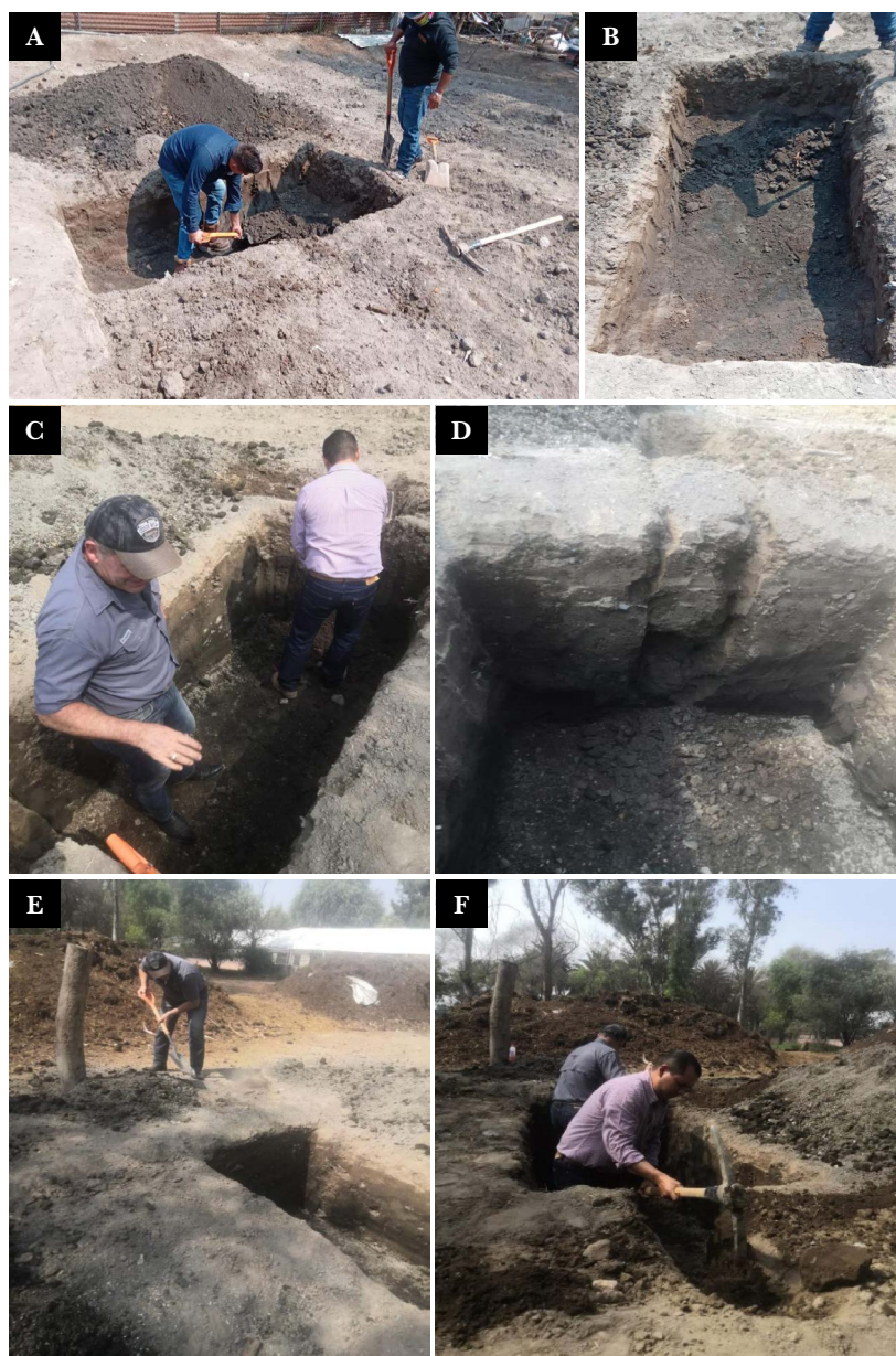
Figura 2. Dimensiones de la fosa realizada en el área de Traspatio del Colegio de Postgraduados. A) Dimensionando el área; B) medidas que se lleva una carbonera 1.5 m de ancho, 1 m de profundidad y 3 m de largo; C) acabado de cada pared para que no se genere obstrucciones; D) área de respiradero; E) colocando la tierra a modo que no quede leños F) realización del área de respiradero (30 cm de ancho) en ángulo de 45°.
