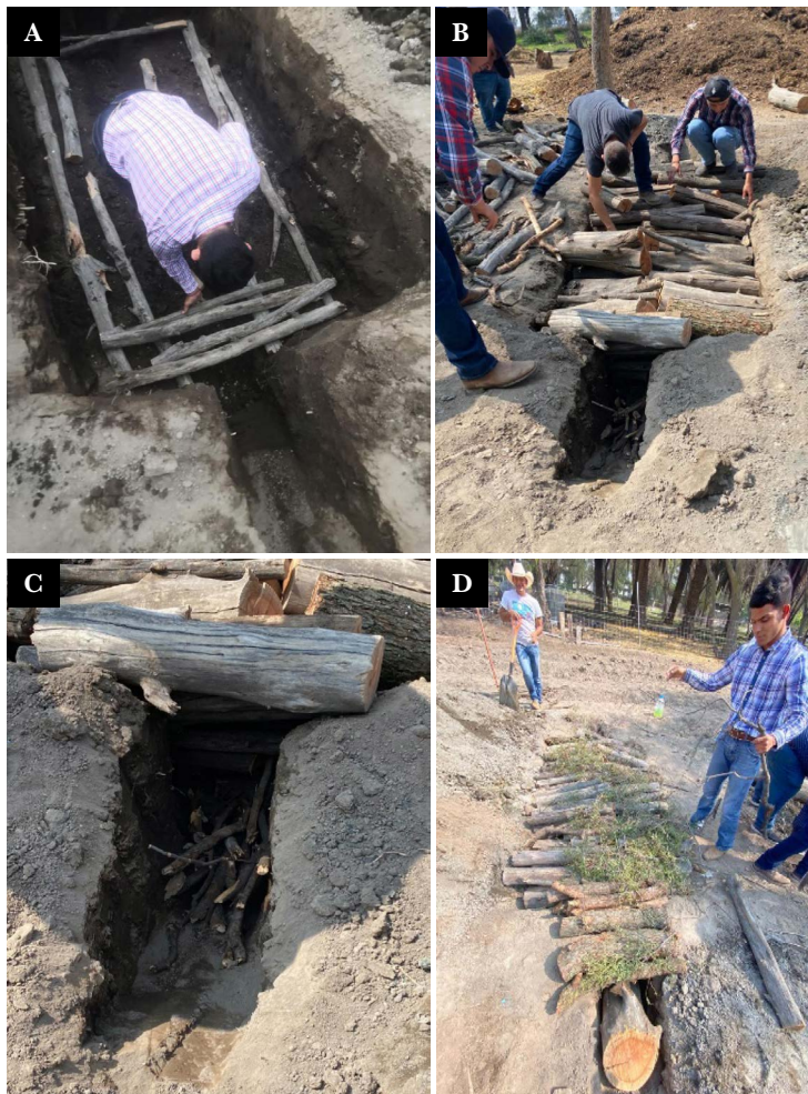
Figura 3. Preparación del llenado de la carbonera. A) Se coloca madera de máximo 5 cm de diámetro para evitar que la leña entre en contacto en el suelo; B) colocación de la leña de forma transversal sobre las varillas; C) borde del acabado de 10 a 15 cm; D) se cubre con forraje verde, ramas sin troncos.
