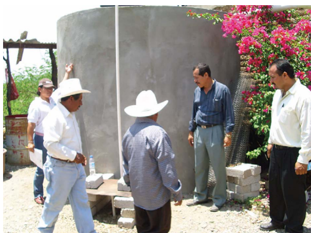
Figura 1. Funcionamiento de una cisterna de ferrocemento para almacenar agua de lluvia en la región Mixteca Poblana de México.
